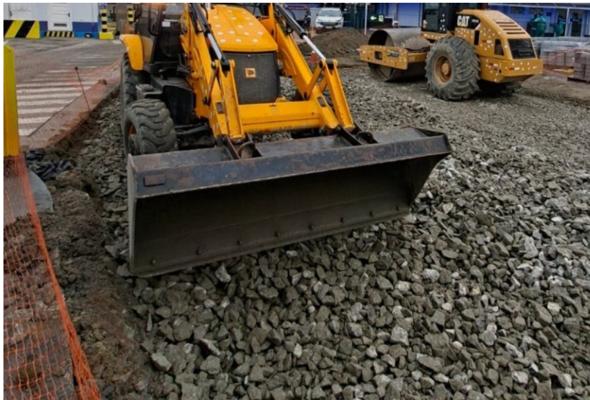
Preparação e regularização de base
